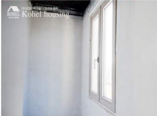
곰팡이 제거 후 단열페인트 시공
