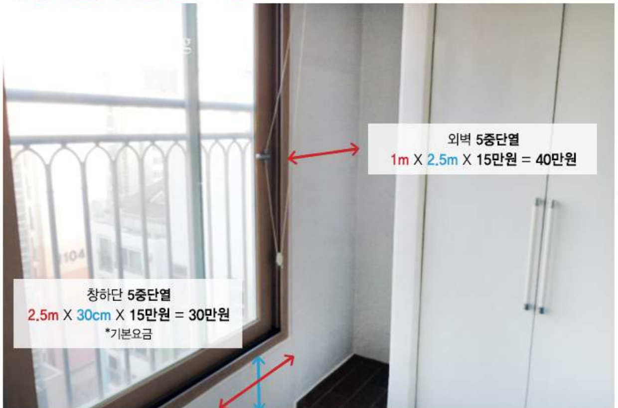
5중단열로 석고보드시공 후 인슐레이 단열페인트 마감공사 완료. (인슐레이 5중단열공사 업계유일 A/S 7년 보장)
