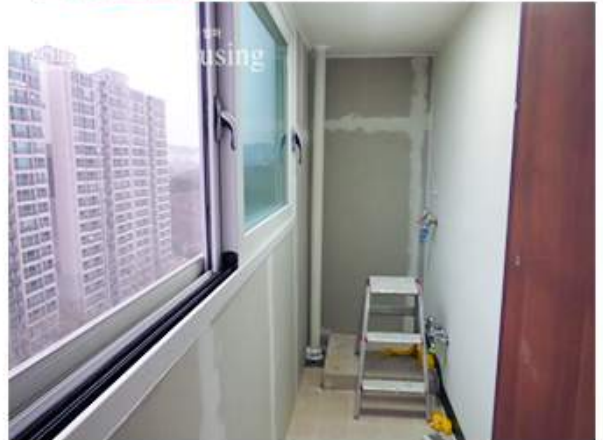
불연재 석고보드로 인슐레이 5중 단열공사를 완료한다.
