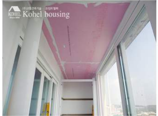
결로방지 단열공사로 인슐레이 5중단열공법으로 문제해결 가능. 천정단열공사는 헤베당 20만원 비용발생. (목공별도)
