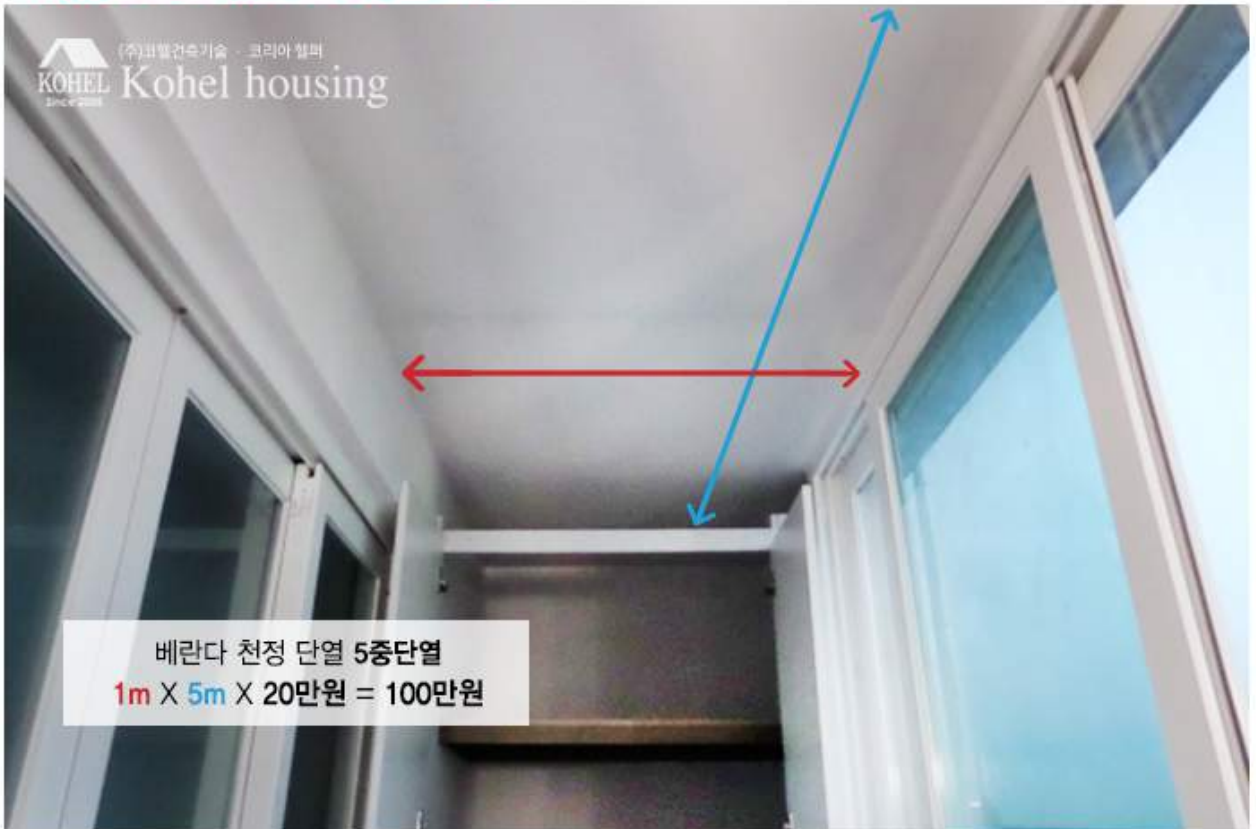
천정목공공사 후 항균단열페인트로 마감처리. 인슐레이 5중 단열공법 업계유일 7년 A/S 보장.
