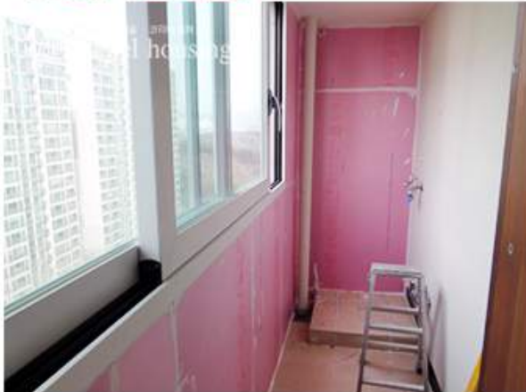
완벽한 기밀을위해 철저한 밀폐 단열공사를 시공.
