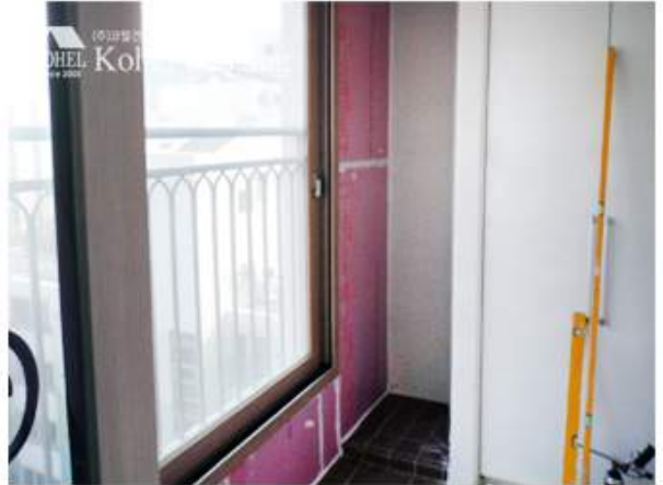
3중, 4중 단열공사 밀폐단열공사 시공함.
